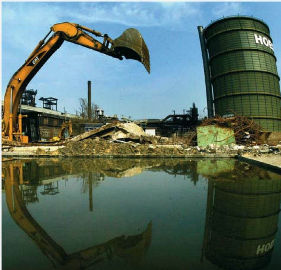
Bis 2001 wurde im letzten Stahlwerk Dortmunds Stahl gekocht – heute gilt die Revitalisierung des PHOENIX-Geländes als zukunftsweisend.
